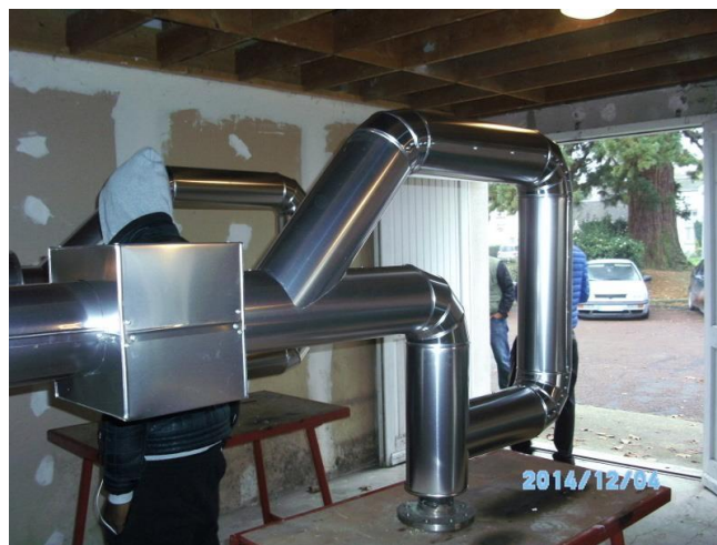
Montage Calorifugeage avec boitier à gant Cubique
